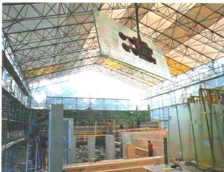
Die ersten Scheiben zum Wasserteil werden «eingeflogen» Foto: RANDO
